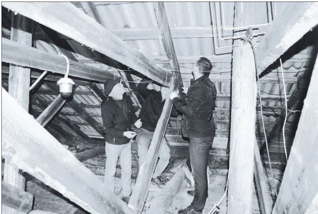
Шубина, 14а. Конечным этапом капитального ремонта дома стала замена кровли
