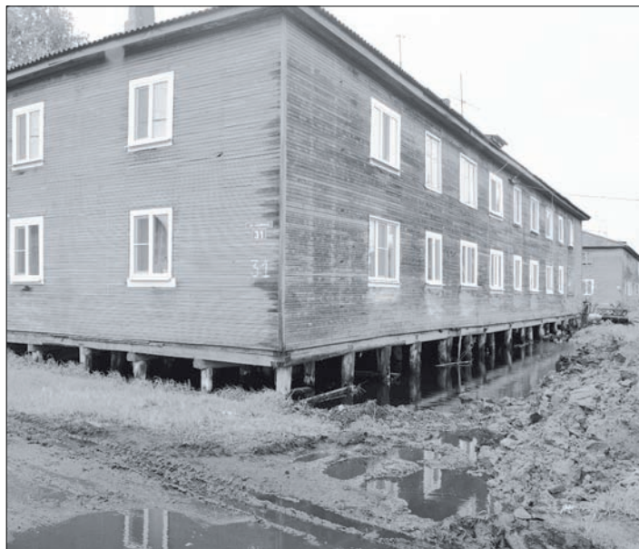
Шубина, 31. Из-под дома сначала нужно откачать воду
