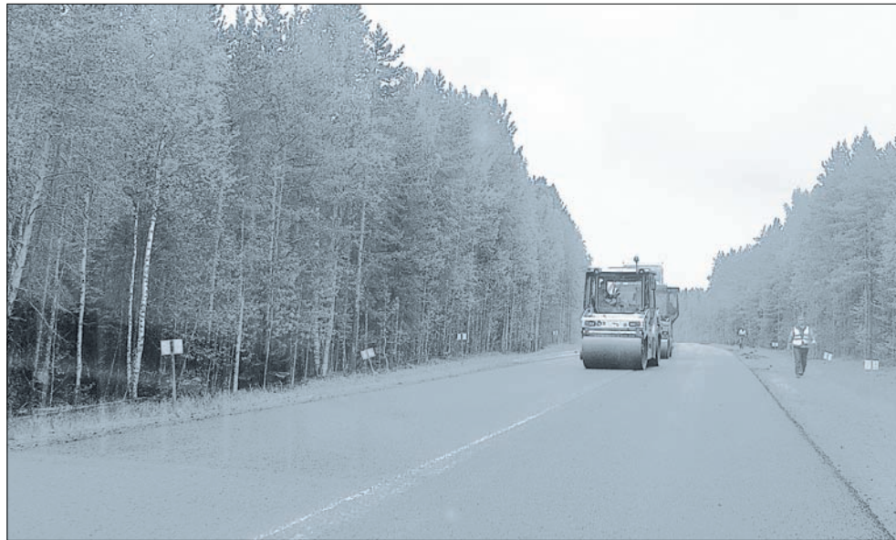
В районе Сии ремонтные работы ведутся на участке с 1072 по 1083 километр
